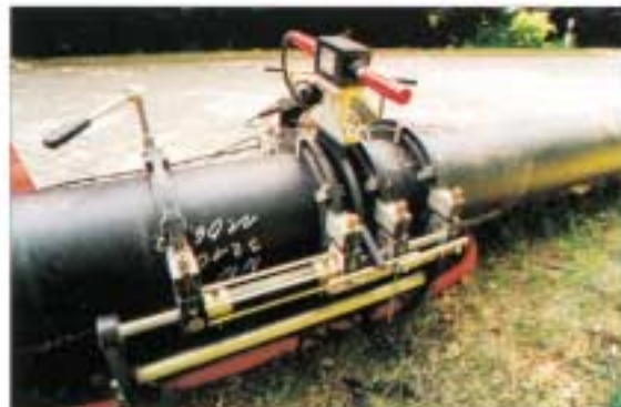
Bild 3: Verschweißen von Rohren aus PE 100 (Typ CRP 100) als Vorbereitung für das Verlegen
